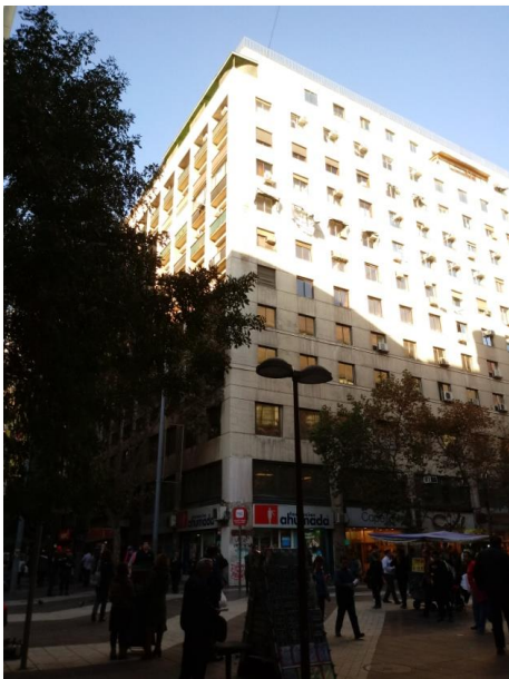
Intersección de las calles Estado y Huérfanos, en la comuna de Santiago, donde se encuentra el edificio que albergó al ex Cine Astor hasta fines de la década de los '80. (Foto del autor)
